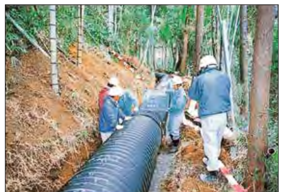
既設水路改修工事
