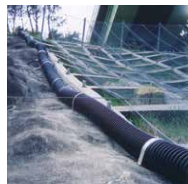
○客先施工例 (NPM-200 法面縦排水管)
