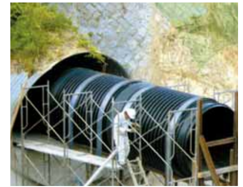
コルゲート管更生工事
