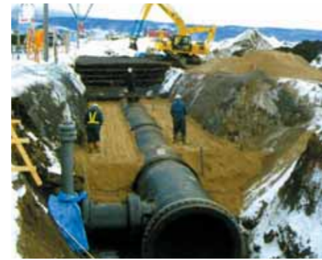
自動溶接継手
