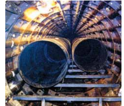
シールド内汚水管布設工事
