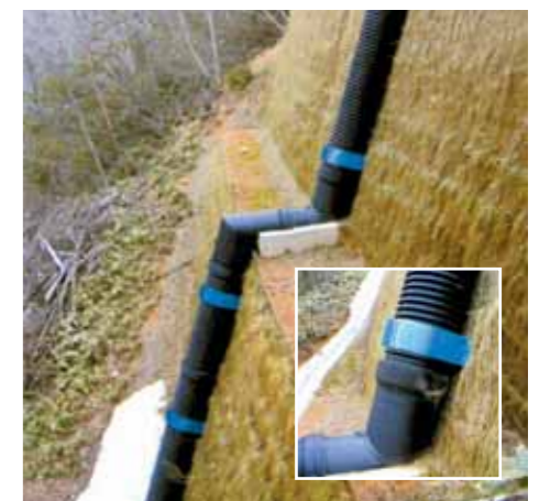
急傾斜露出配管
